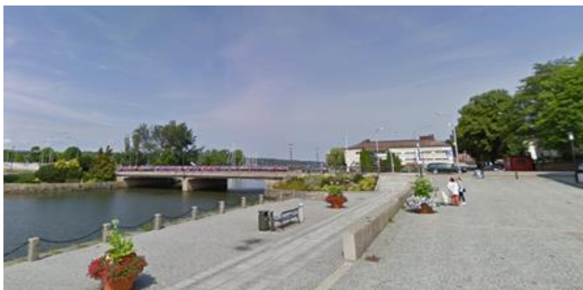
Figur 6-3. Översvämningsskydd enligt princip D, mur med öppningar i Vänersborg. Källa Vänersborgs kommun.
