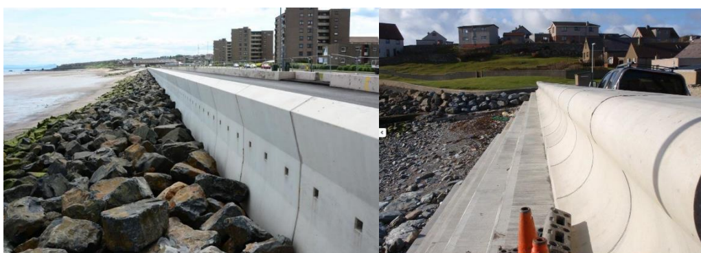
Figur 6-5. Exempel på vågskydd med bullnose (Moore Concrete, 2021).
