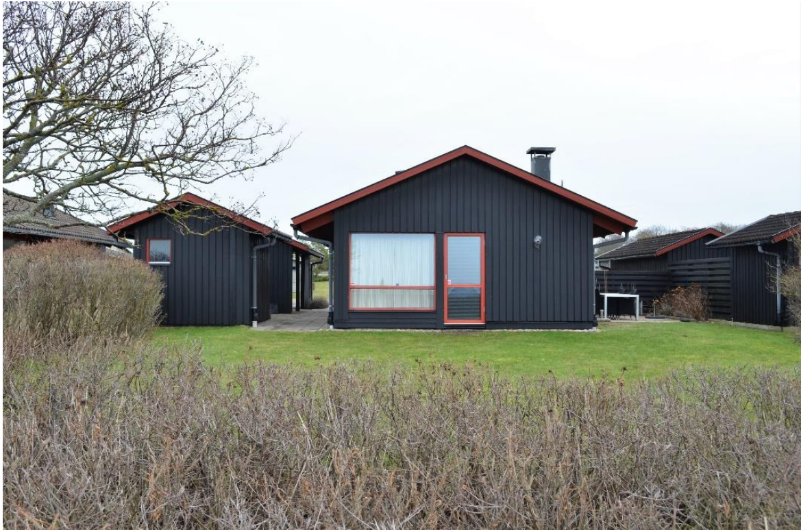
Andelsstugorna byggda under 1970- och 1980-talet är till stor del identiska och skiljer sig främst åt genom att vara målade i olika kulörer (röd, svart, gråblå).
