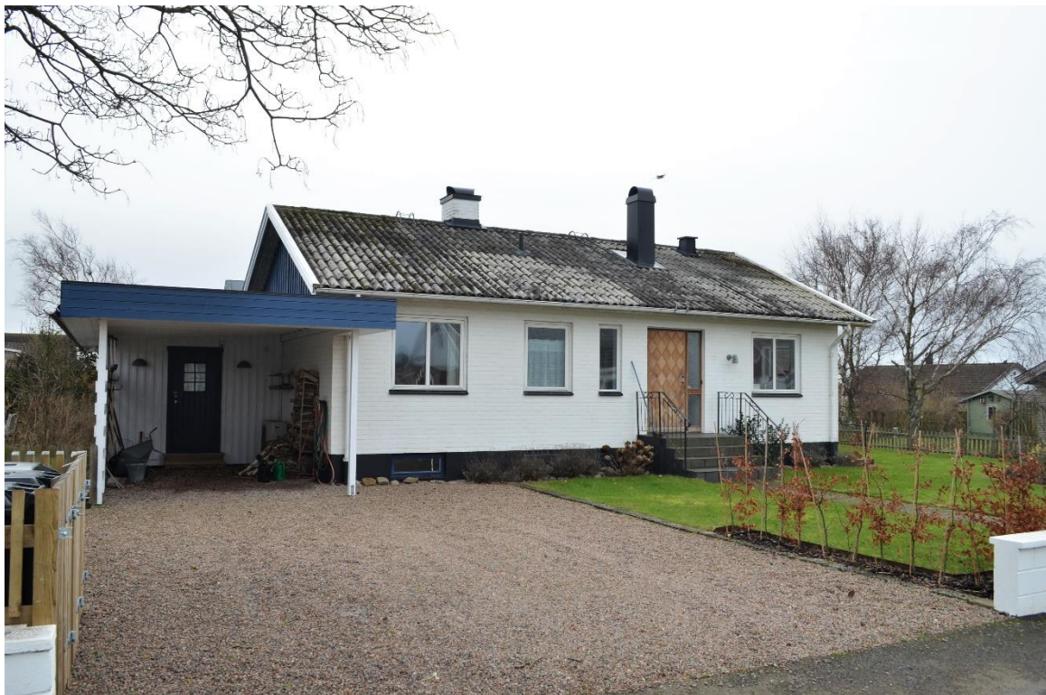
En tidstypisk villa från 1960-talet med ljus tegelfasad, en- och tvåluftsfönster, ädelträddörr med sidoljusfönster och smidesräcke vid entrétrappan.
